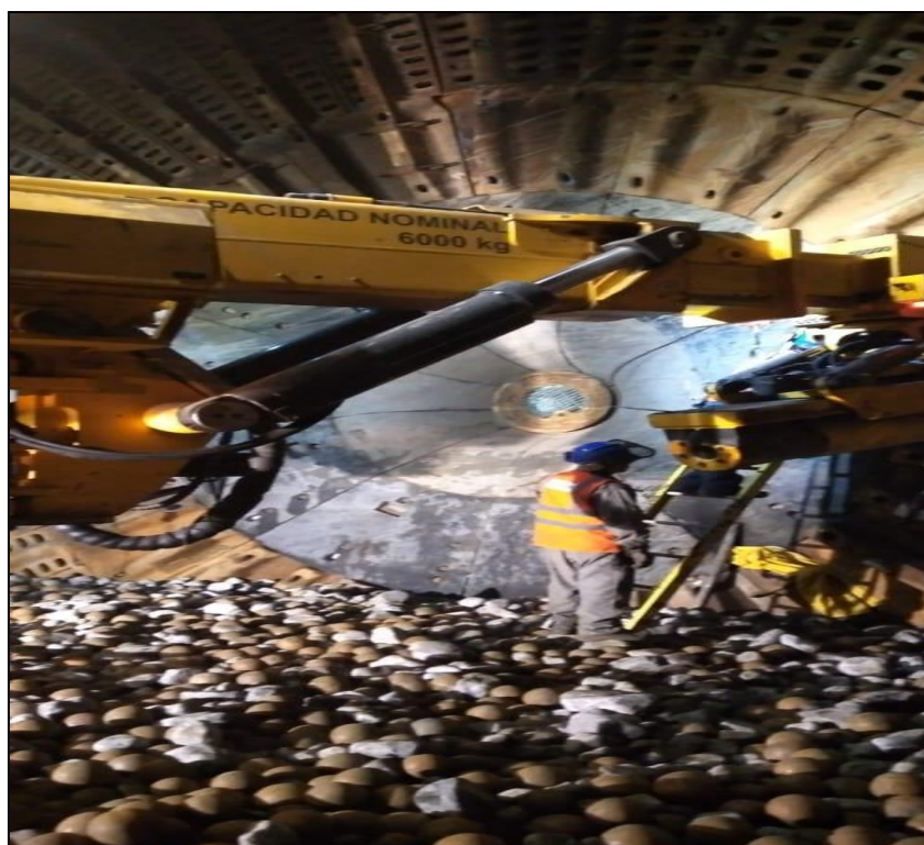
Fotografía 4: Cambio de liner en el interior de Molino SAG
