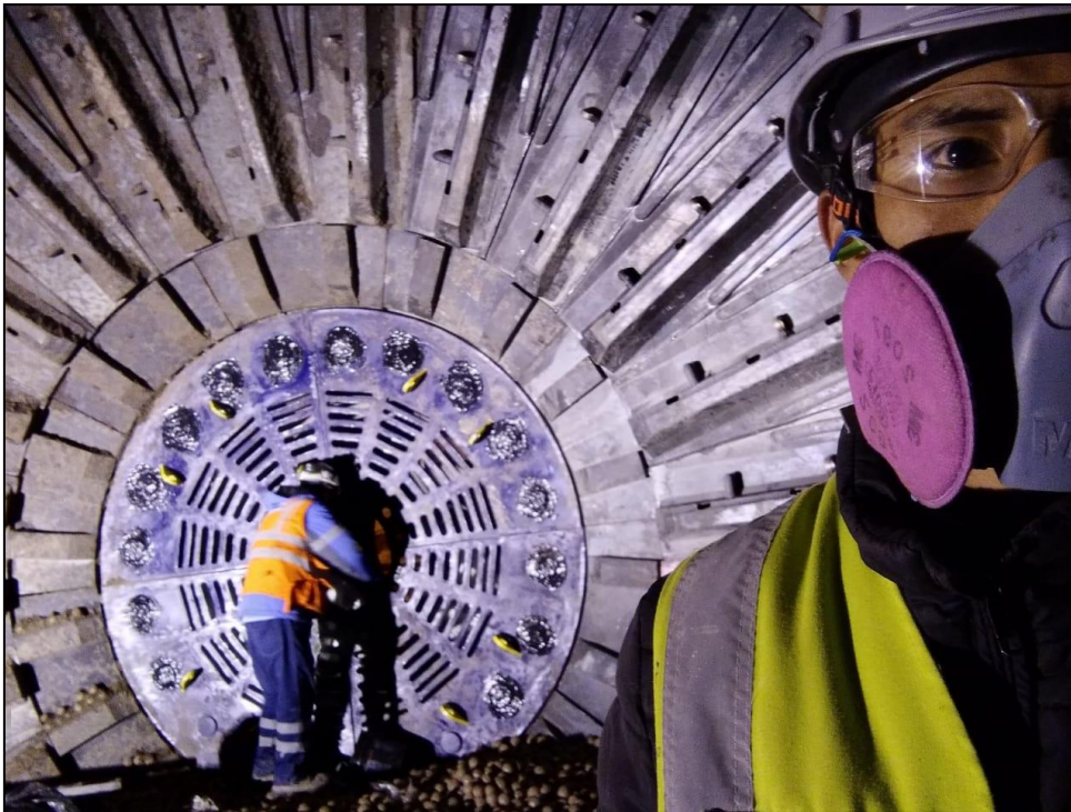
Fotografía 6: Cambio de liners en Molino de Bolas
