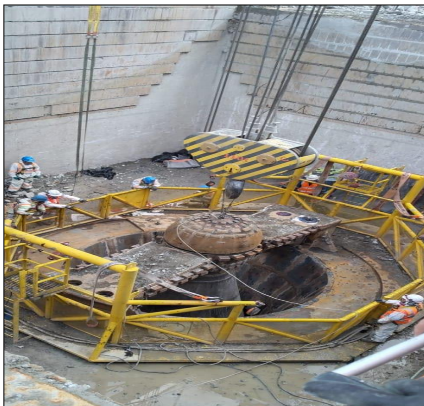
Fotografía 5: Cambio de Main Shaft en Chancador Primario
