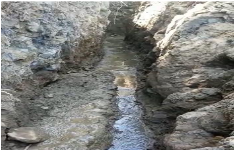
Nota. Excavación de zanja en área de afloramiento para salida a gravedad (2021).
