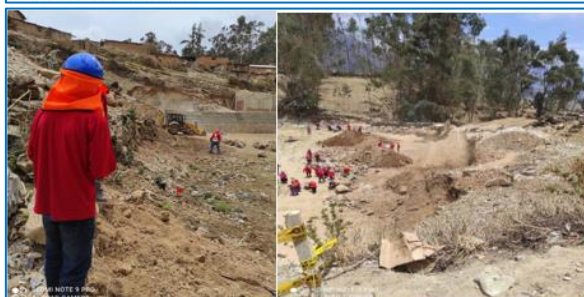
Foto 5. Vista fotográfica de perfilado y nivelación de terreno normal. 24/11/2021
