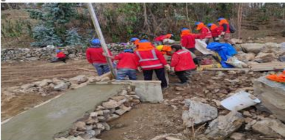
Foto 8. Vista fotográfica vaciado de concreto ciclópeo de la cuarta grada. 15/12/2021
