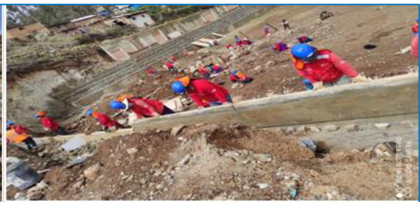
Foto 2. Vista fotográfica de encofrado y vaciado de concreto ciclópeo de la segunda grada. 01/12/2021
