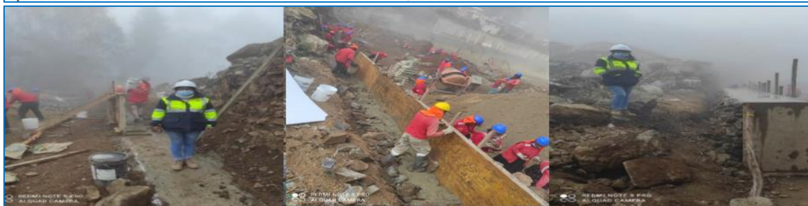
Foto 9. Vista fotográfica de encofrado y vaciado de concreto en 35 m. de largo por 1.20 m de la pantalla del muro. 27/11/2021 y 28/11/2021
