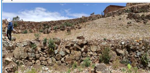
Foto 3. Vista fotográfica del terreno antes de iniciar las respectivas actividades. 18/11/2021
