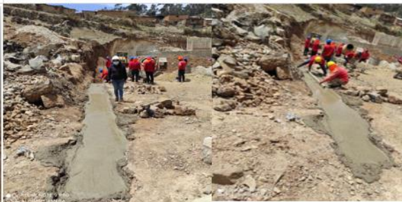
Foto 8. Vista fotográfica de vaciado de concreto en base para muro. 26/11/2021
