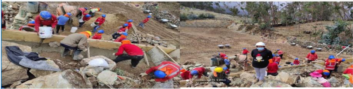
Foto 11. Vista fotográfica de encofrado y vaciado de concreto ciclopeo 1:10 + 30% PG en grada N° 01. 30/11/2021
