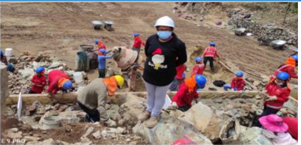
Foto 6. Vista fotográfica de vaciado de concreto ciclópeo en la tercera grada. 13/12/2021
