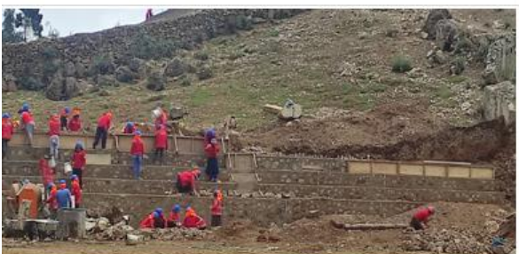
Foto 7. Vista fotográfica de encofrado de la cuarta grada. 14/12/2021
