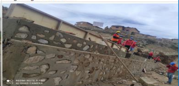
Foto 4. Vista fotográfica de desencofrado de la segunda grada y encofrado y vaciado de concreto ciclópeo de la tercera grada. 03/12/2021
