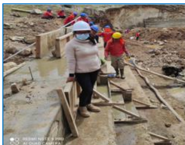
Foto 9. Vista fotográfica de encofrado y vaciado de concreto en gradenería y espaltar para la cuarta grada. 16/12/2021 y 17/12/2021
