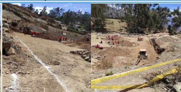
Foto 6. Vista fotográfica en excavación de Zanja para cimiento de muro. 25/11/2021
