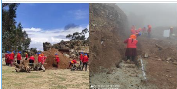
Foto 7. Vista fotográfica de selección de material (piedra de 8" a 10") para el pircado del muro. 26/11/2021
