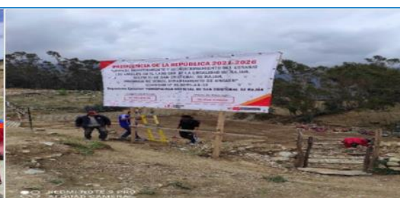
Foto 2. Vista fotográfica de instalación de cartel de actividad. 18/11/2021
