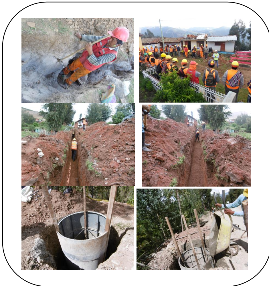
Instalación de Tubería de 160mm en Gasajpampa
