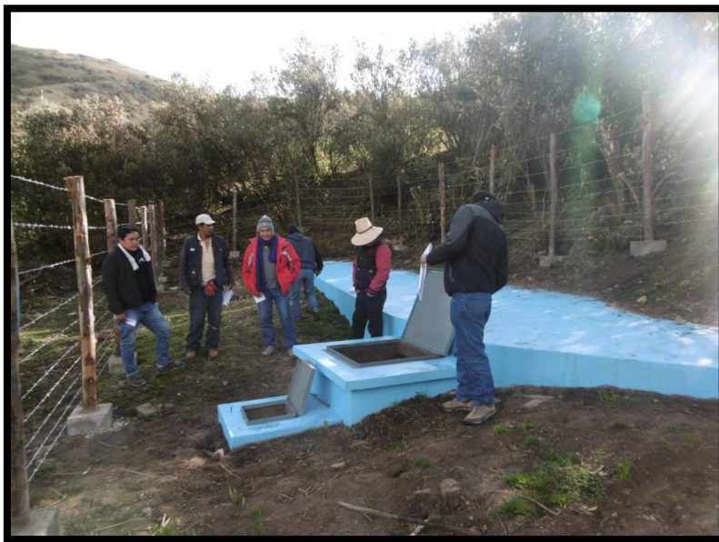
Captación de Waricocha
