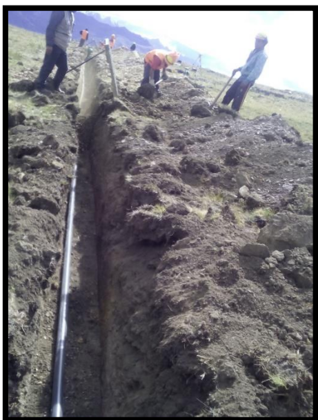
Relleno con Material Propio Seleccionado
