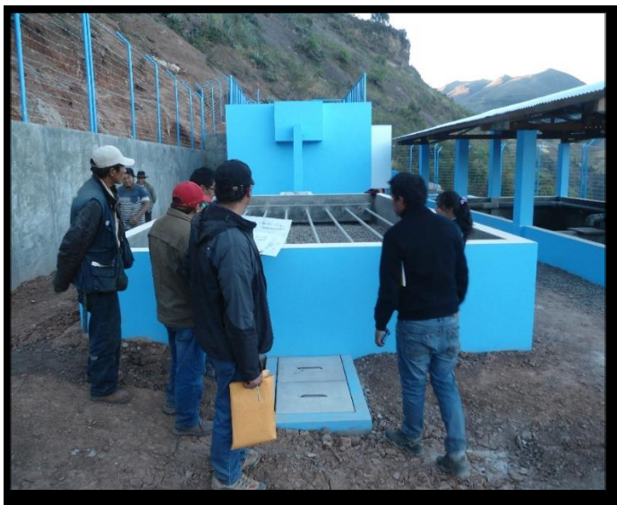
Planta de Tratamiento en Pirpo
