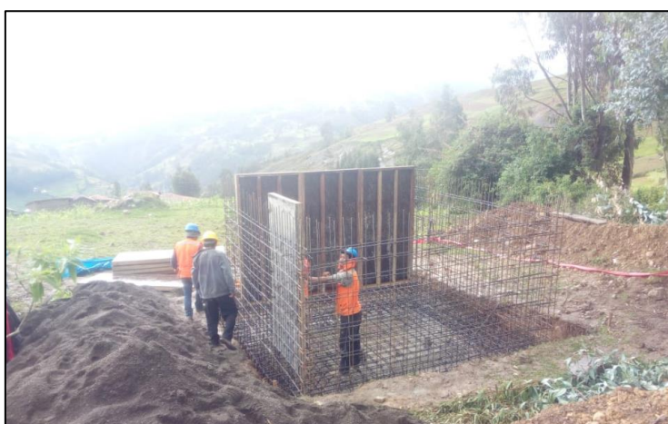
Acero de refuerzo para los reservorios
