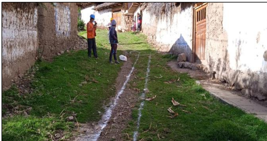
Trazo de zanja para tubería
