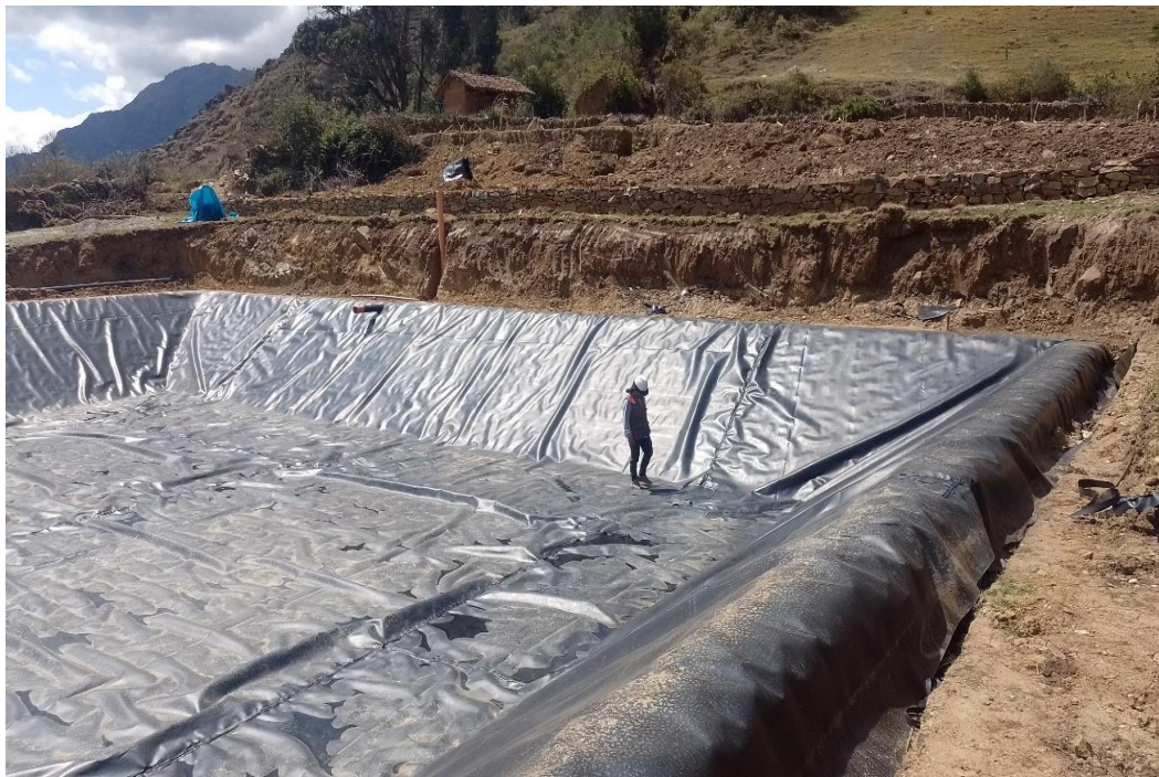
Nota: se puede apreciar la verificación del tendido de la geo membrana para el reservorio.
