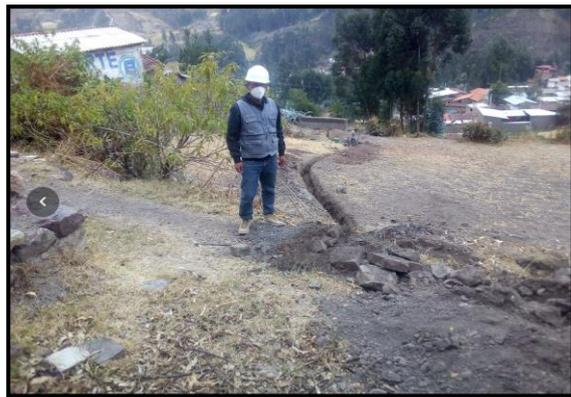
*Nota.* Captura fotográfica de los trabajos de verificación de excavación e instalación de las redes de distribución del sistema de riego.
