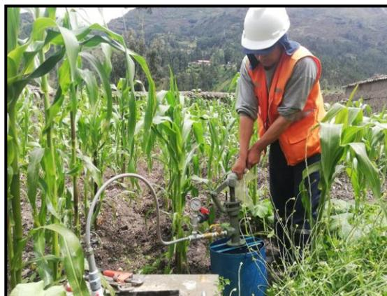
*Nota.* Captura fotográfica de los trabajos de prueba hidráulica en tuberías HDPE en las redes de distribución del sistema de riego.
