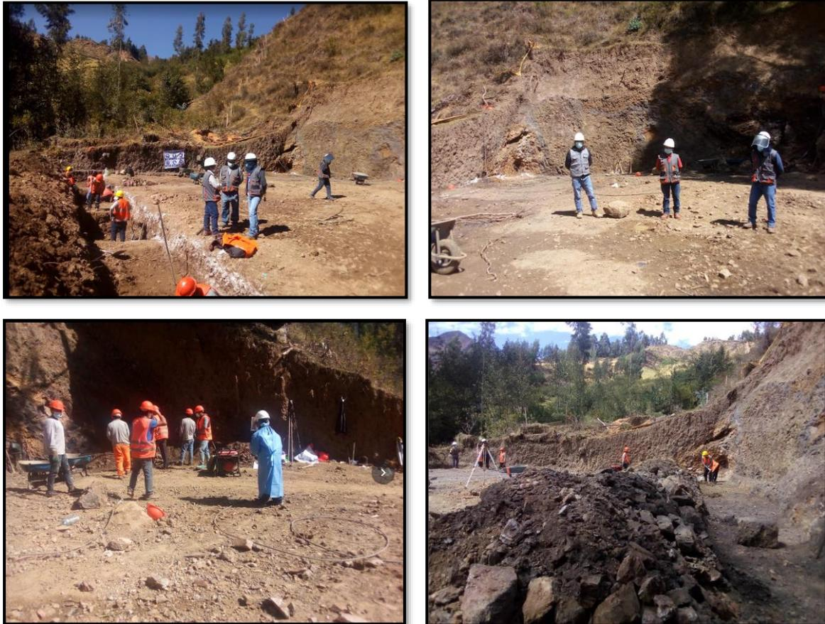
*Nota: Captura fotográfica de los trabajos de verificación de la excavación del área donde se construyó el reservorio de 500m<sup>3</sup>.*
