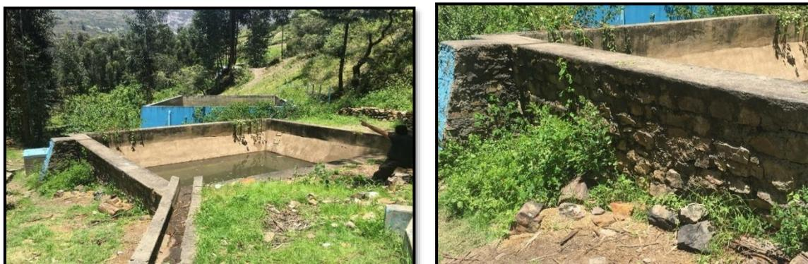
*Nota.* Tras las verificaciones realizadas y con el apoyo del personal de la obra se encontró que el espacio disponible para la construcción del nuevo reservorio es de un área menor al proyectado en los planos del Expediente Técnico de Obra.
