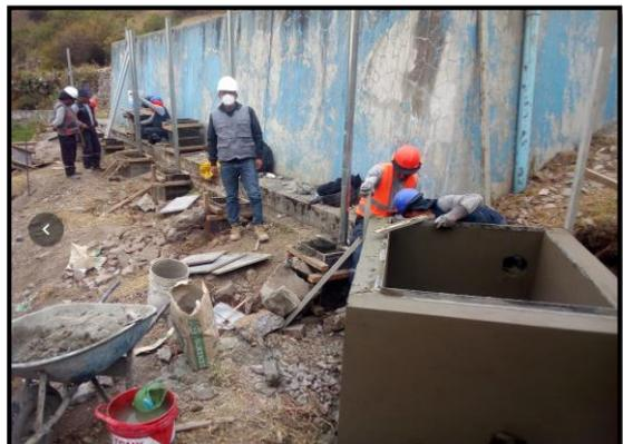
*Nota.* Captura fotográfica de los trabajos de verificación de la construcción de cajas de válvulas en los diferentes sectores del sistema de riego.
