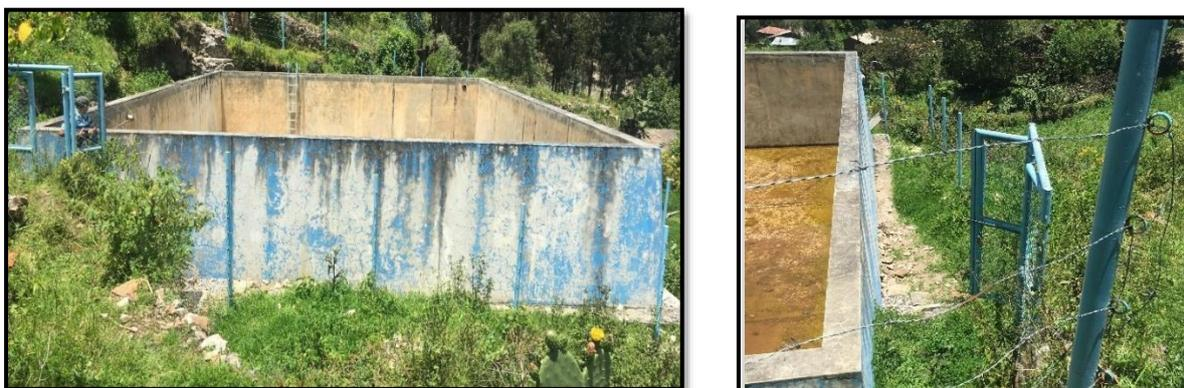
*Nota:* En la imagen se aprecia el estado situacional del reservorio existente en el sector Callcash, también se verifico el estado del cerco perimétrico metálico que se encuentra en mal estado.
