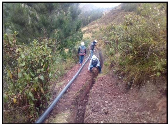
*Nota.* Captura fotográfica de la verificación de los trabajos de instalación de redes de distribución de tubería HDPE con termofusión.
