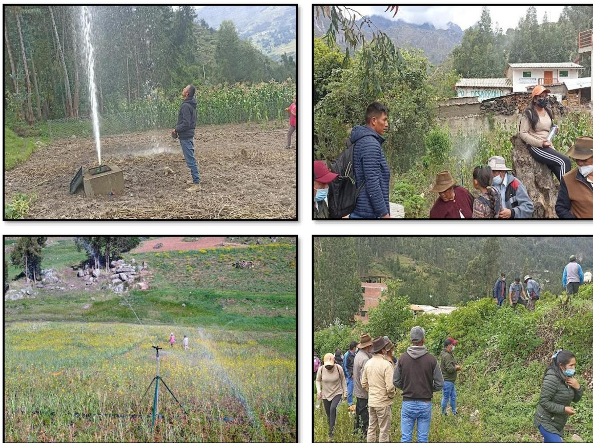
*Nota:* Captura fotográfica de las pruebas realizadas al sistema de riego ya culminado, se hizo una verificación junto con la población en las cuales se verifico el funcionamiento de los aspersores.
