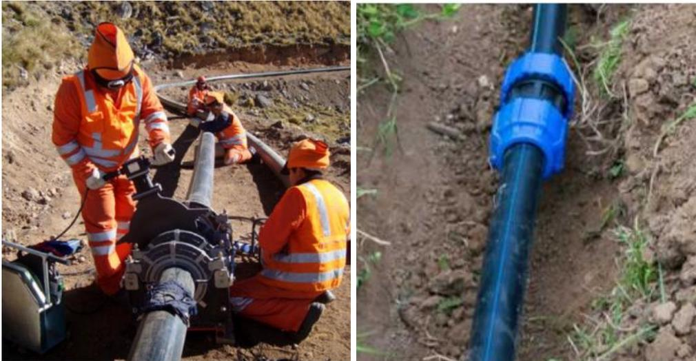
Nota. En la figura de la izquierda se aprecia el procedimiento de unión de tuberías mediante la termofusión y el suso de equipo especial. En la figura izquierda se aprecia el uso de acoples de compresión que son económicos pero la limitante es que se solo se usa hasta diámetros de 110mm.
