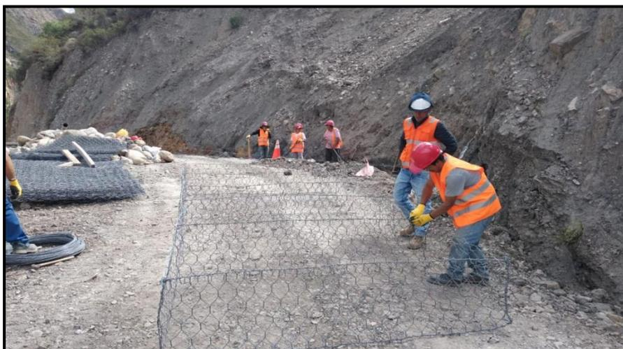
*Nota.* La figura muestra los trabajos de verificación de procesos constructivos del armado de gaviones para muros de contención en carreteras.
