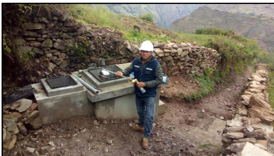
*Nota.* La figura muestra los trabajos de verificación de procesos constructivos de instalación de válvula flotadora en cámara rompe presión tipo 7.
