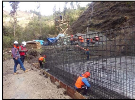
*Nota.* Captura fotográfica de los trabajos de verificación de la instalación del acero de refuerzo  $f_y=4200 \text{ kg/cm}^2$  en los muros del reservorio del sector Cashua.
