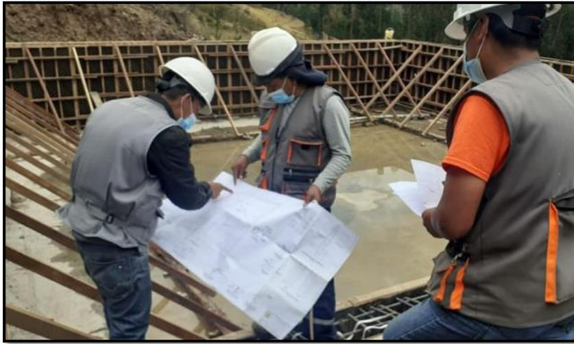
Nota: La figura muestra los trabajos de verificación de procesos constructivos de encofrado de reservorio de 500m<sup>3</sup> del sistema de riego tecnificado en el centro poblado de Carash.
