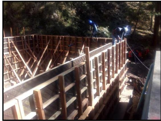
*Nota.* Captura fotográfica de los trabajos de encofrado de muros con paneles de triplay fenólico del reservorio del sector de Callcash.
