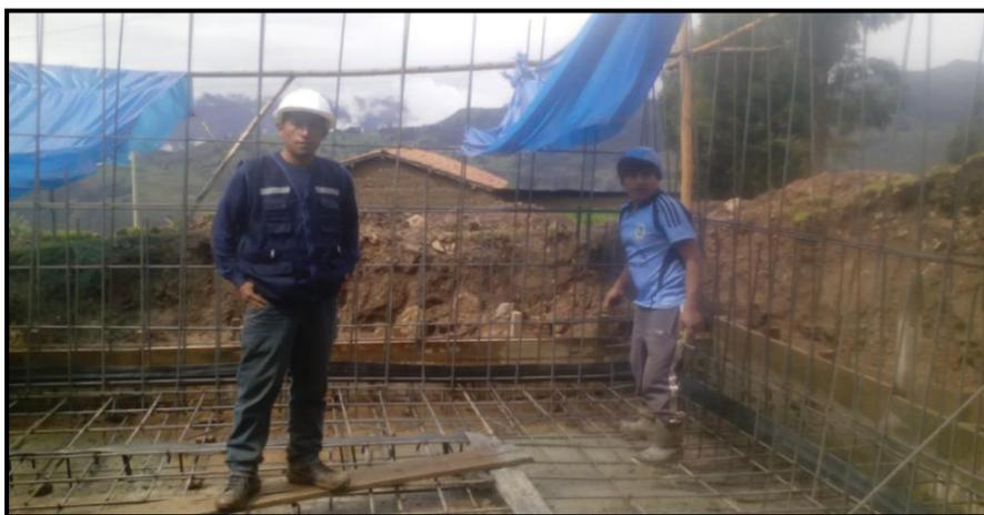
*Nota.* La figura muestra los trabajos de verificación de procesos constructivos de la construcción del reservorio de 150 m<sup>3</sup> del sistema de riego.
