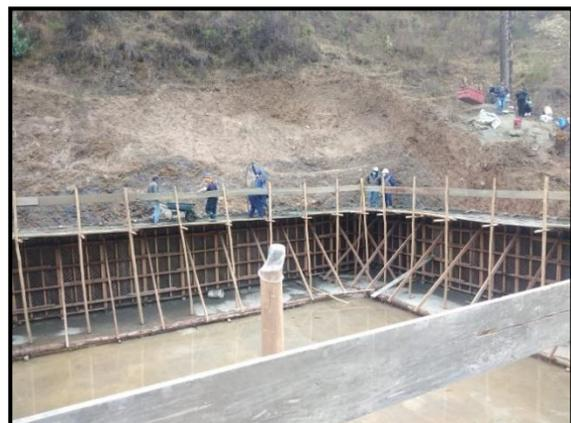
*Nota.* Captura fotográfica de los trabajos encofrado con paneles de triplay fenólico en el reservorio 500m<sup>3</sup> del sector de Cashua.
