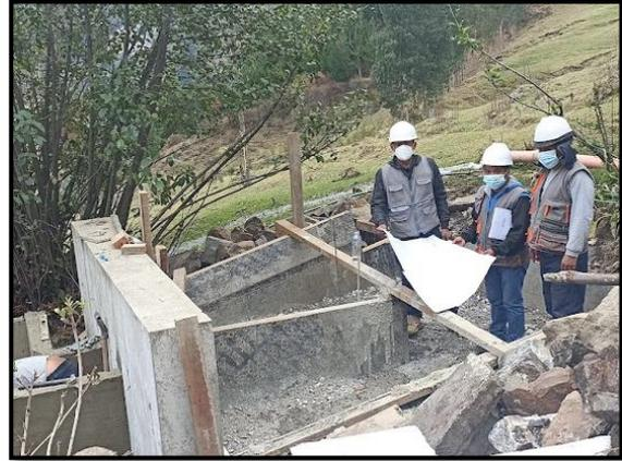
*Nota.* Captura fotográfica de la verificación de los trabajos construcción de la bocatoma y el desarenador en el sistema de riego del sector Cashua.
