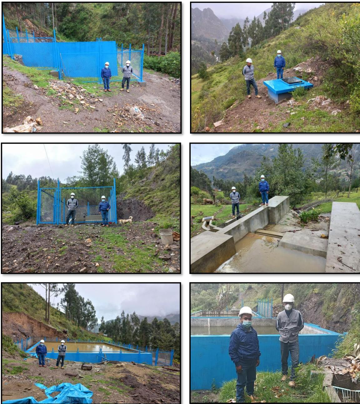
*Nota.* Captura fotográfica de la verificación de la culminación del reservorio del sector Cashua, reservorio del sector Callcash, desarenador y bocatoma del sector Cashua, como se aprecia en las capturas el sistema se encuentra en funcionamiento
