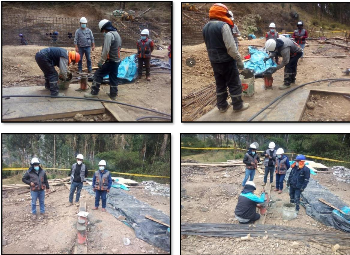
*Nota.* Captura fotográfica de la toma de muestras para el ensayo de compresión de del concreto
