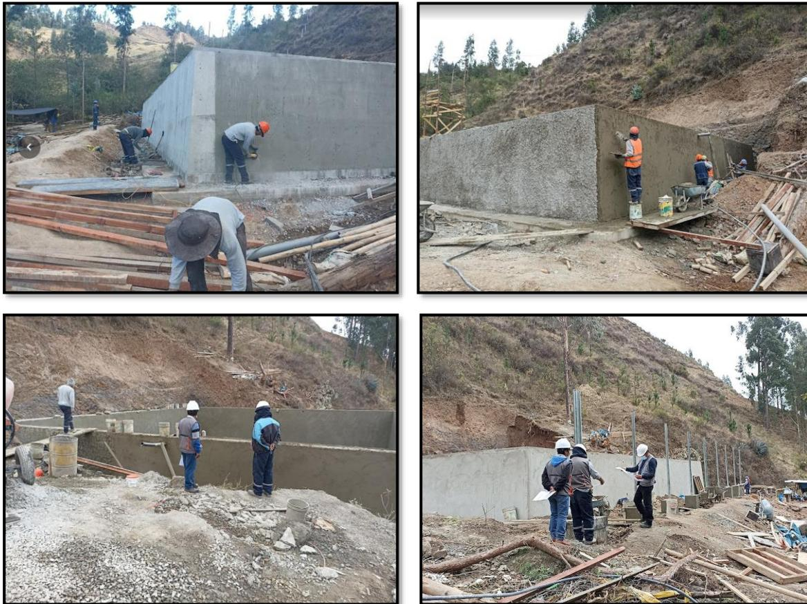
*Nota.* Captura fotográfica de la verificación de los trabajos de tarrajeo en muros del reservorio e instalación del cerco metálico del sector de Cashua.
